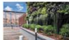
TERRASSE VÉGÉTALISÉE 145 m 2
