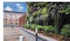
TERRASSE VÉGÉTALISÉE 145 m 2
