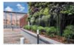
TERRASSE VÉGÉTALISÉE 145 m 2
