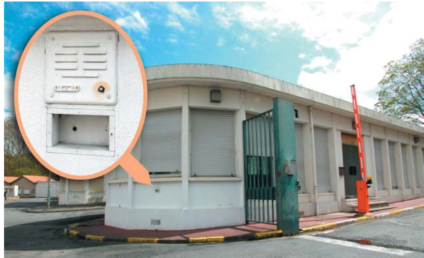
Vestige d'un passé pas si lointain : à l'ancienne entrée de l'Hôtel Dieu, à Poitiers, il reste encore l'interphone qui était en communication directe avec la maternité. Il permettait notamment aux familles de prévenir anonymement le service de l'abandon d'un enfant.
