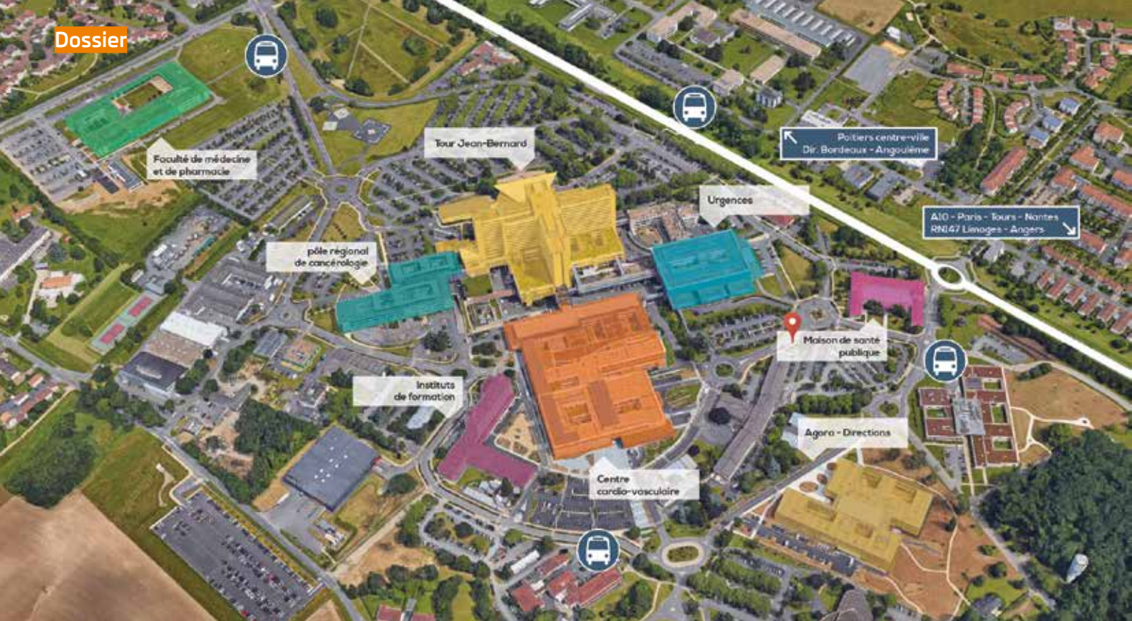
La structure est un point central entre hôpital et ville, entre proximité et rayonnement territorial.
