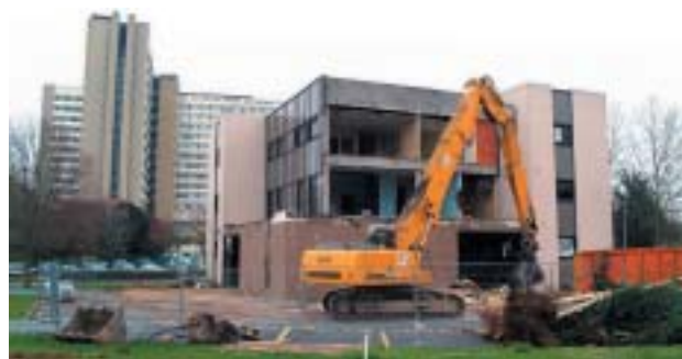
L'ancien bâtiment du Samu-Smur Centre 15 a été déconstruit. C'est à cet endroit précis que seront coulées les fondations du pôle régional de cancérologie.
