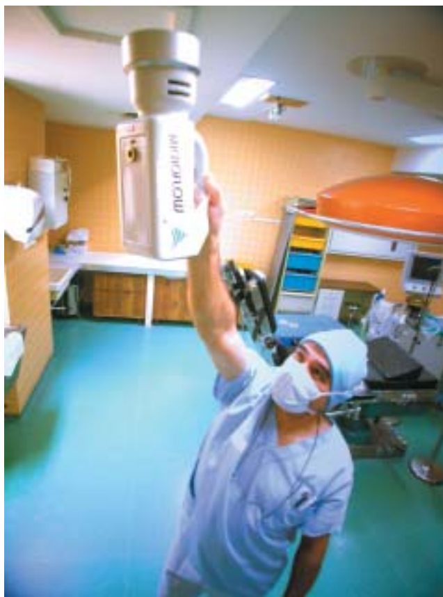
L'air des blocs opératoires est contrôlé régulièrement.
